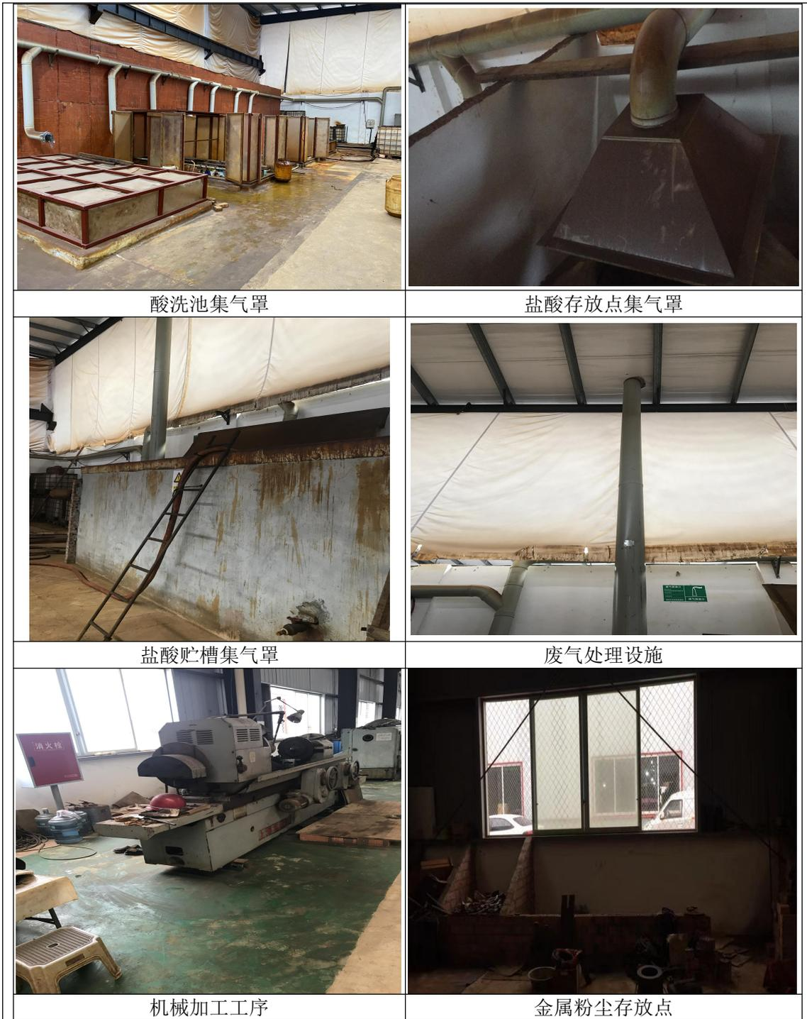
图 4-1 本项目废气处理设施图
