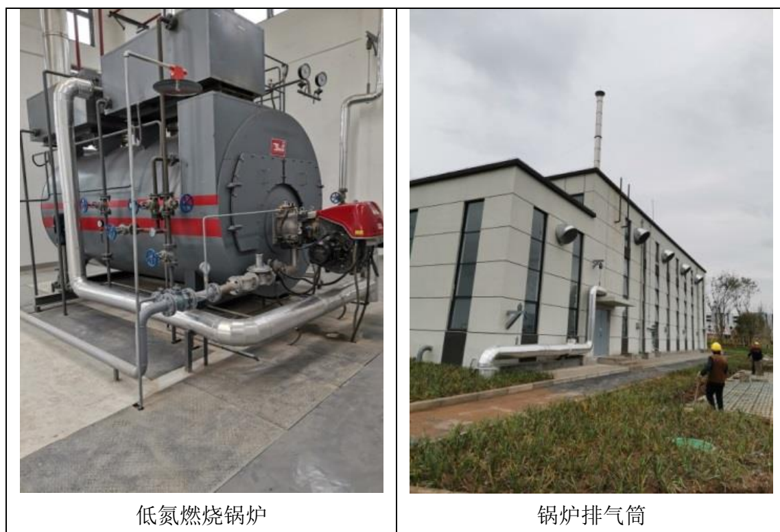
图 4-6 低氮燃烧锅炉及排气筒
