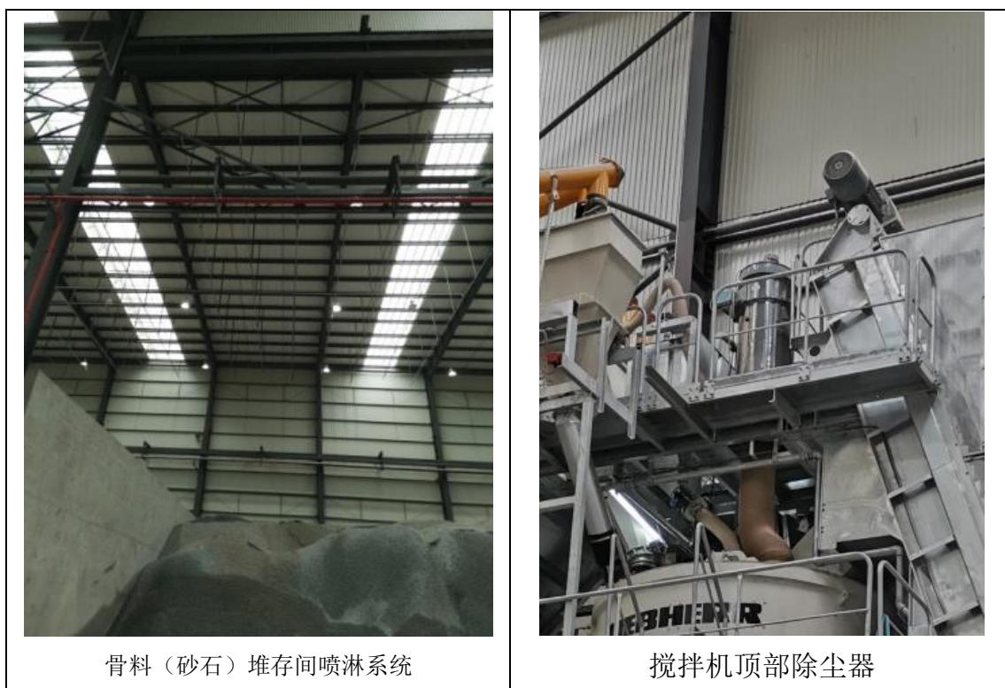
图 4-4 原料水喷淋及搅拌机除尘器
