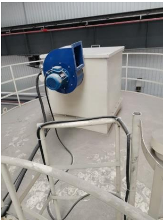
图 4-5 料仓筒脉冲除尘器
