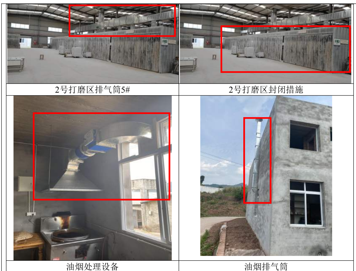
图 4-1 本项目废气处理设施图
