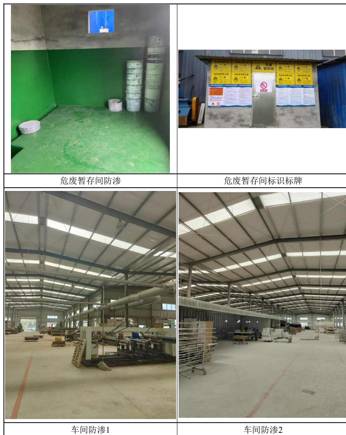
图 10-1 已采取的地下水防渗措施
