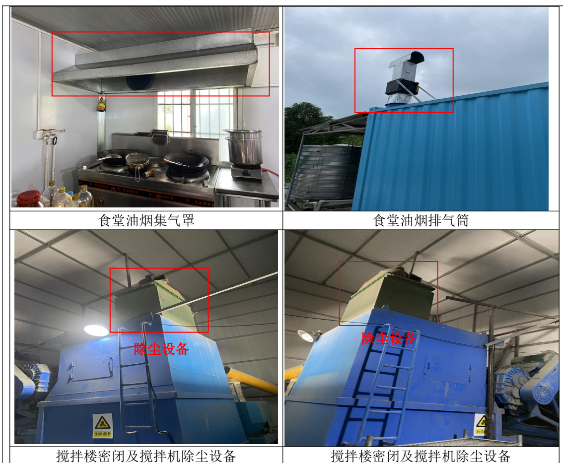
图 4-1 本项目废气处理设施图
