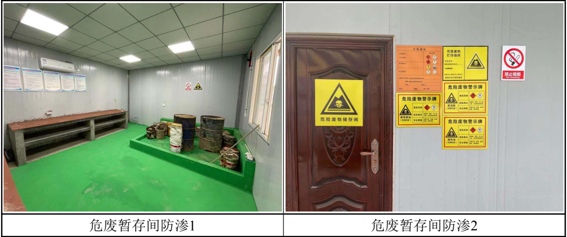
图 10-1 已采取的地下水防渗措施
