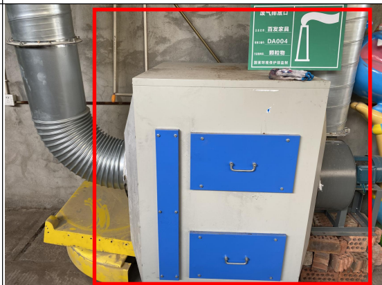
2#车间喷漆废气处理设施
