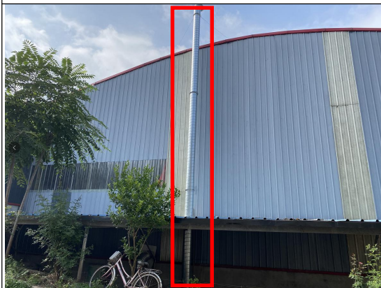
2#车间喷漆废气排气筒3#
