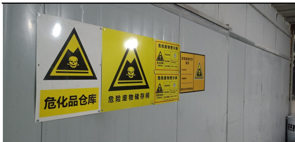
危废暂存间标志标牌
