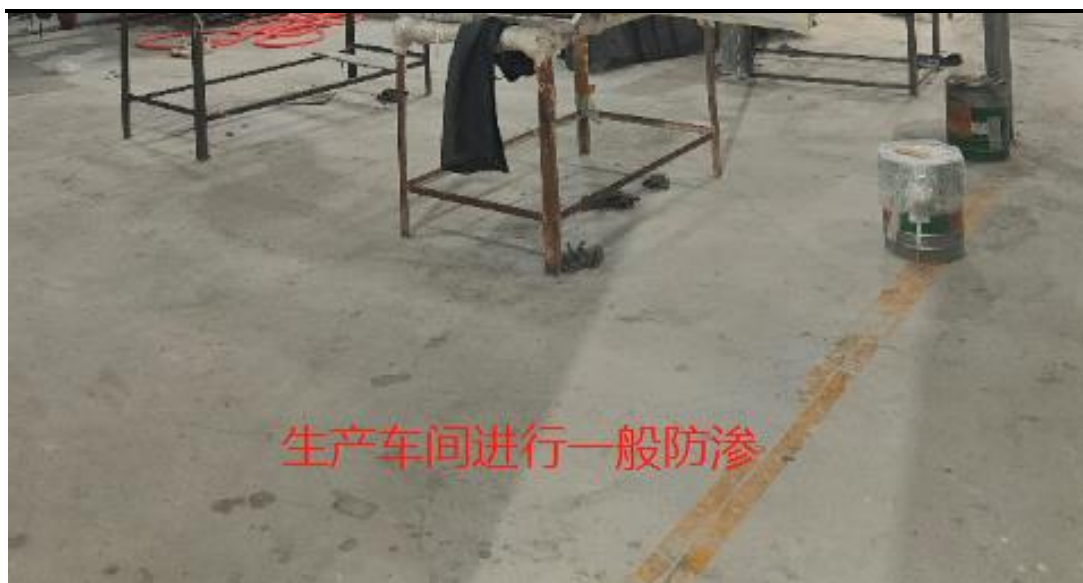
车间地面进行了一般防渗
