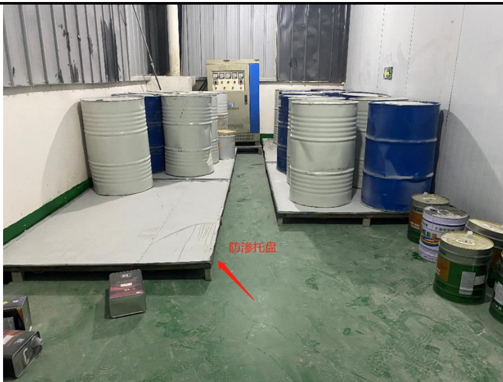
危废暂存间地面防渗+防渗托盘
