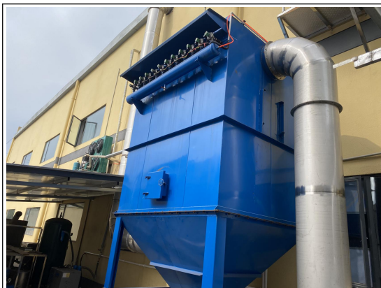
固体饮料车间废气处理设施
