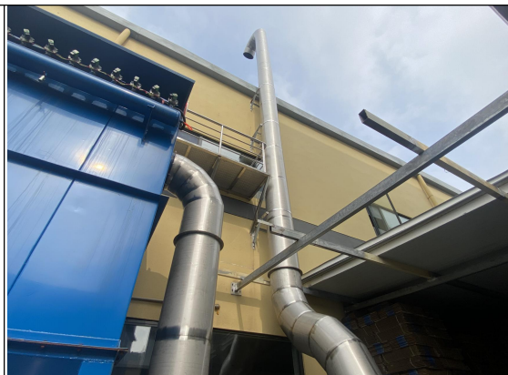
固体饮料车间废气处理设施排气筒
