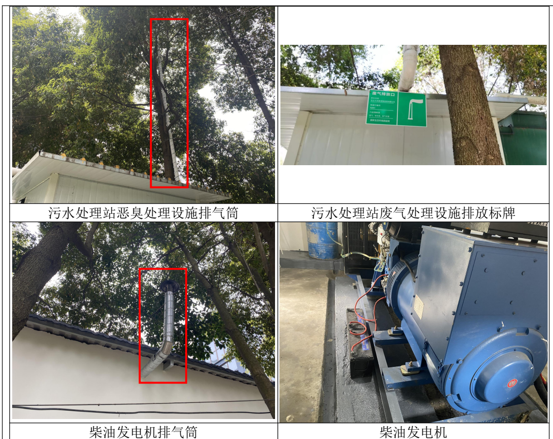
图 4-1 本项目废气处理设施图
