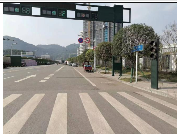
道路标识牌实景图 2
