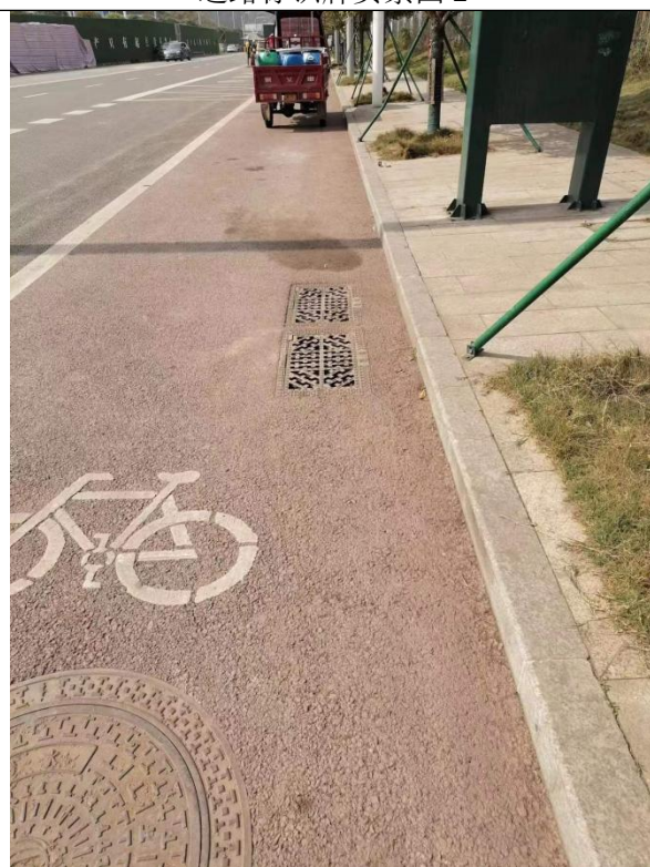
道路两侧排水沟渠实景图 2
