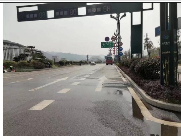
道路标识牌实景图 1
