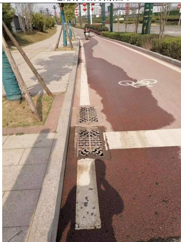
道路两侧排水沟渠实景图 1
